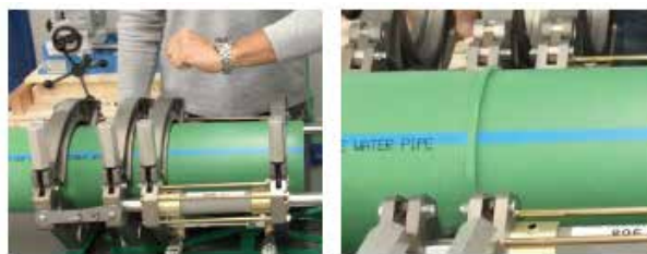
Slika br. 44: Čeonog zavarivanje
