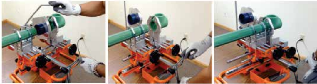
Slika br. 39: Postupak zavarivanja i hlađenja cevi i fittinga
