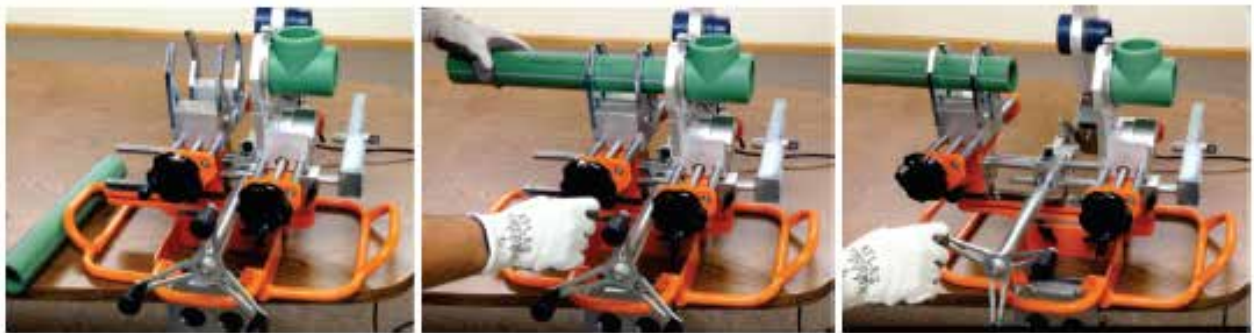
Slika br. 37: Postupak poravnanja cevi i fittinga
