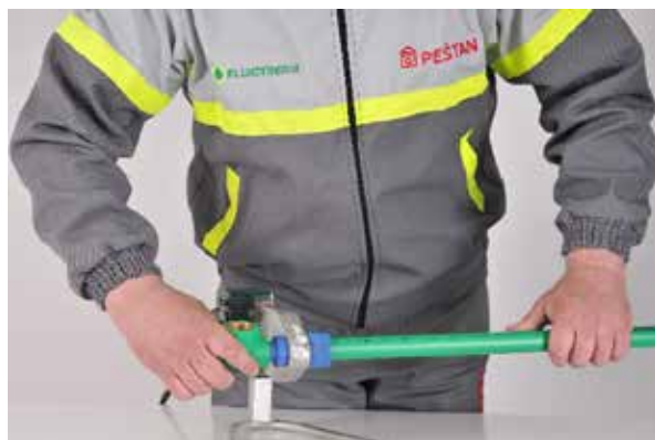
Slika br. 23: Zagrevanje cevi i fittinga (obratiti pažnju na upravnost cevi i fittinga na grejnu ploču)
