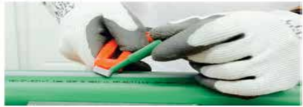
Slika br. 49: Odsecanje viška reparacionog čepa
