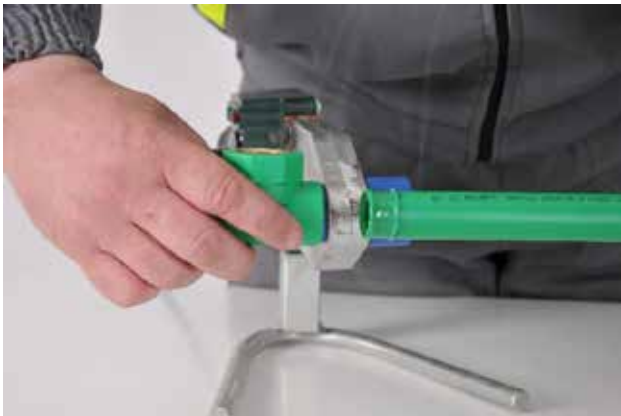
Slika br. 24: Spajanje cevi sa fittingom
