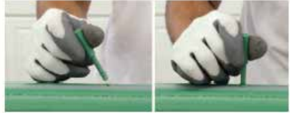
Slika br. 48: Insertacija reparacionog čepa
