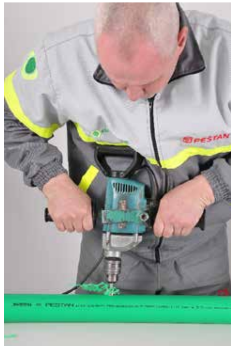
Slika br. 27: Postupak bušenja zida cevi svrdlom
