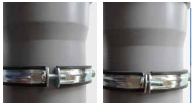
Prikaz opuštene i zategnute obujmice na cevima
