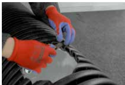
5. Obrada rupe za sag i čišćenje opiljaka
