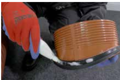
6. Podmazivanje gumice na telu saga
