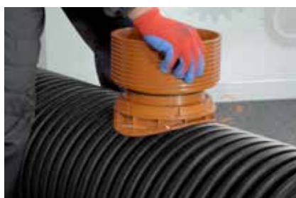
11. Postavljanje odabranog priključka
