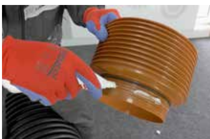
10. Podmazivanje odgovarajućeg priključka za sag
