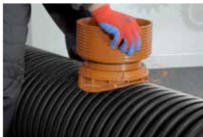
11. Postavljanje odabranog priključka
