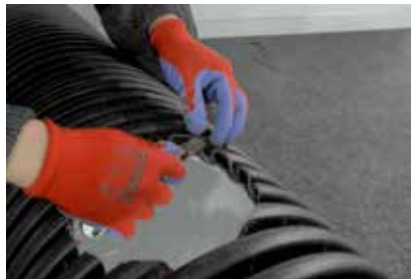
5. Obrada rupe za sag i čišćenje opiljaka
