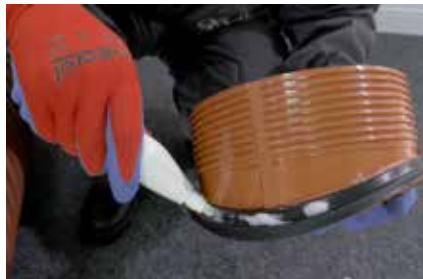
6. Podmazivanje gumice na telu saga
