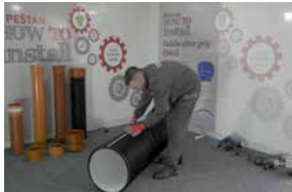
2. Odeđivanje pozicije za montažu
