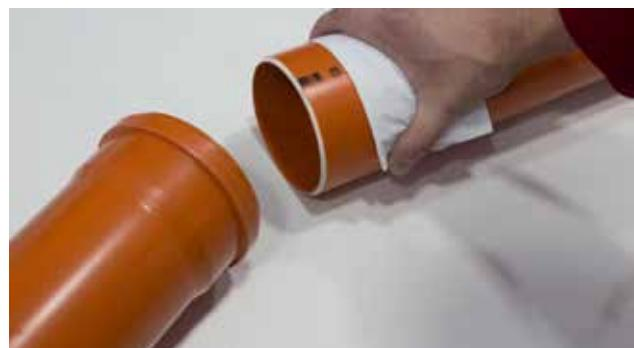
2. Nakon čišćenja cevi prekontrolisati stanje zaptivnih elemenata.
