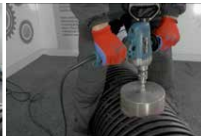
4. Bušenje rupe krunastom testerom
