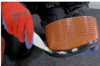
6. Podmazivanje gumice na telu saga
