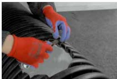
5. Obrada rupe za sag i čišćenje opiljaka
