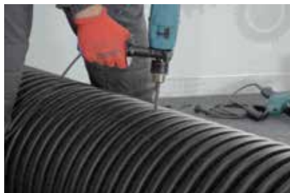
3. Bušenje rupe za vodilicu krunaste testere
