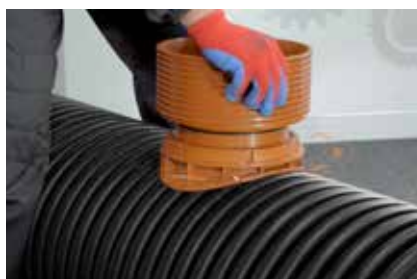
11. Postavljanje odabranog priključka
