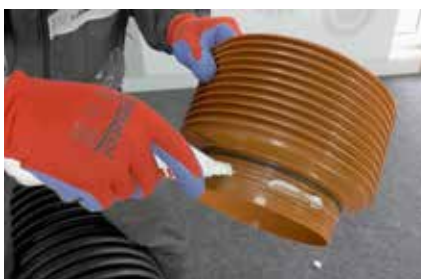
10. Podmazivanje odgovarajućeg priključka za sag
