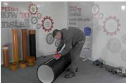
2. Odrješivanje pozicije za montažu
