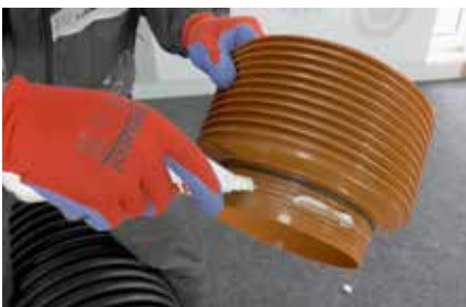
10. Podmazivanje odgovarajućeg priključka za sag
