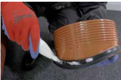
6. Podmazivanje gumice na telu saga
