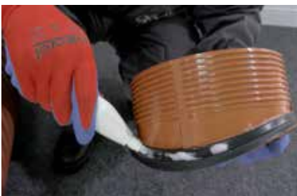
6. Podmazivanje gumice na telu saga
