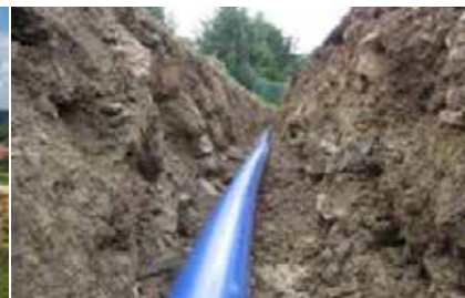
postavljanje bez peščane posteljice
