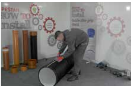
2. Odrješivanje pozicije za montažu
