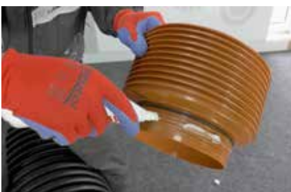
10. Podmazivanje odgovarajućeg priključka za sag
