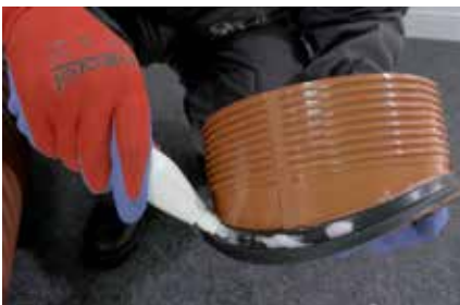
6. Podmazivanje gumice na telu saga
