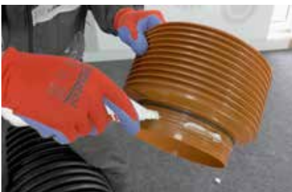
10. Podmazivanje odgovarajućeg priključka za sag
