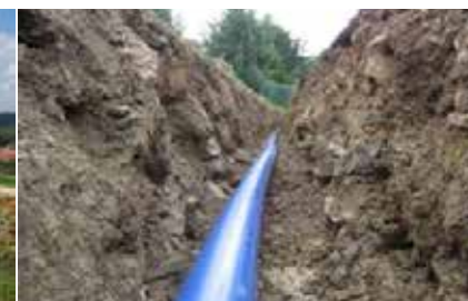
postavljanje bez peščane posteljice
