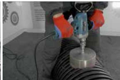
4. Bušenje rupe krunastom testerom
