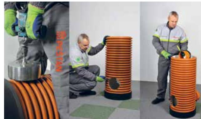
U skladu sa uputstvom za montazu SAG-a postaviti priključke na visinu koji zahteva situacija na terenu, pri postavljanju uzeti u obzir željenu dubinu taložnika. Moguće je postaviti priključak bilo gde po obodu cevi. Zahvaljujući ovoj metodi moguće je napraviti i kaskadne priključke.
