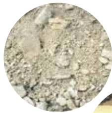
OŠTEĆENJA OD TAČKASTOG OPTEREĆENJA
