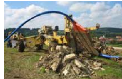
postavljanje bez kopanja otvorenog rova, metoda polaganja oranjem.
