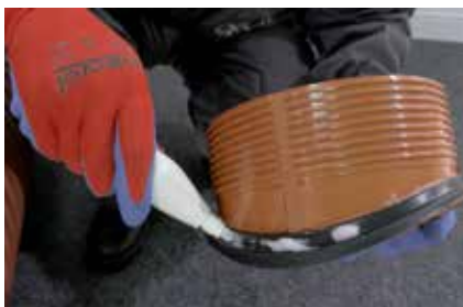
6. Podmazivanje gumice na telu saga
