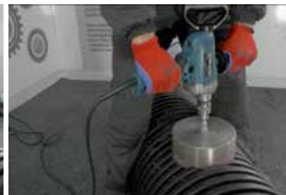
4. Bušenje rupe krunastom testerom
