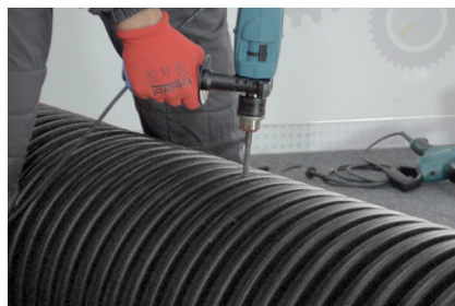
3. Bušenje rupe za vodiču krunaste testere
