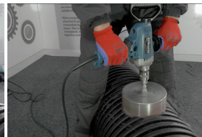
4. Bušenje rupe krunastom testerom
