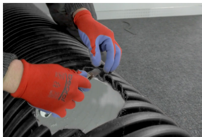
5. Obrada rupe za sag i čišćenje opiljaka
