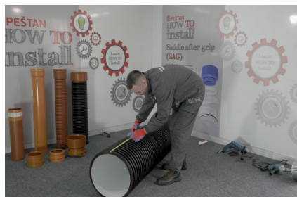
2. Oderedivanje pozicije za montažu
