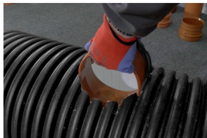
7. Ubacivanje tela saga kroz unapred pripremljeni otvor i postavljanje u odgovarajuću poziciju
