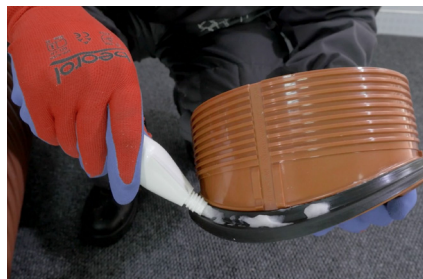
6. Podmazivanje gumice na telu saga
